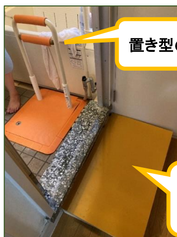
木製の踏み台で 段差解消
